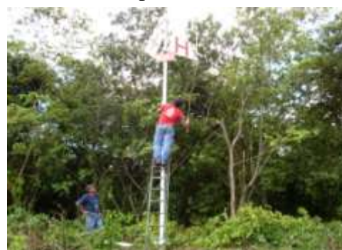
Limpeza de pintura das placas
