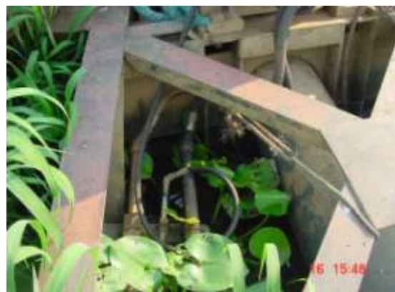
Troca de Mangueiras Hidráulicas
