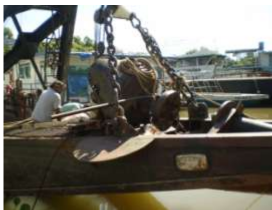
Troca de Mangueiras Hidráulicas.
