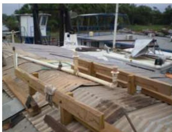
Reforma da Estrutura da caixa d'água
