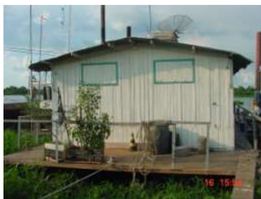
Reforma da Casa Flutuante
