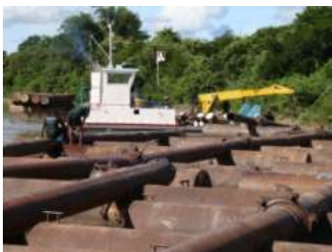
Montagem de linhas
