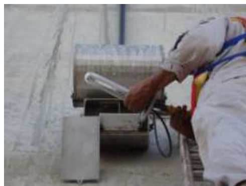
Substituição de lâmpadas dos pilares
