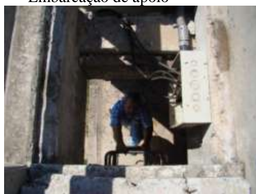
Acesso para interior da ponte
