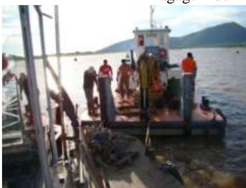
Substituição de cabo de aço de varredura
